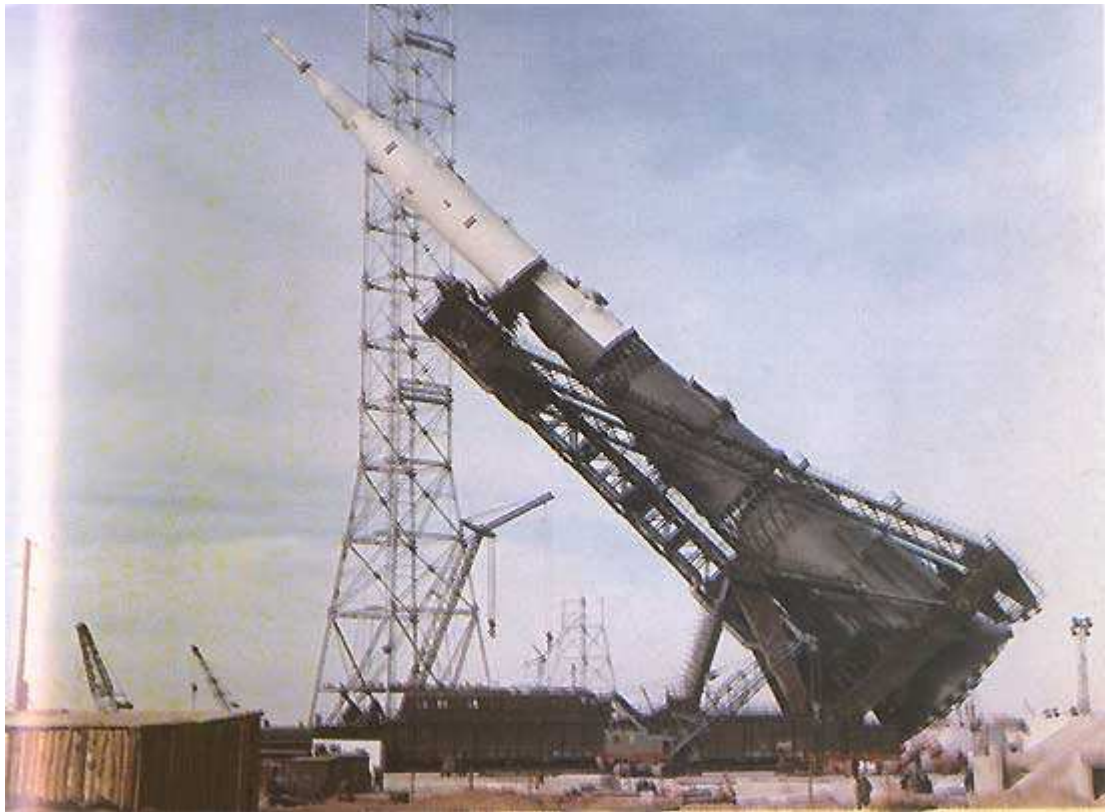
Вывоз и установка ракеты Н1. Панорама стартовых позиций
