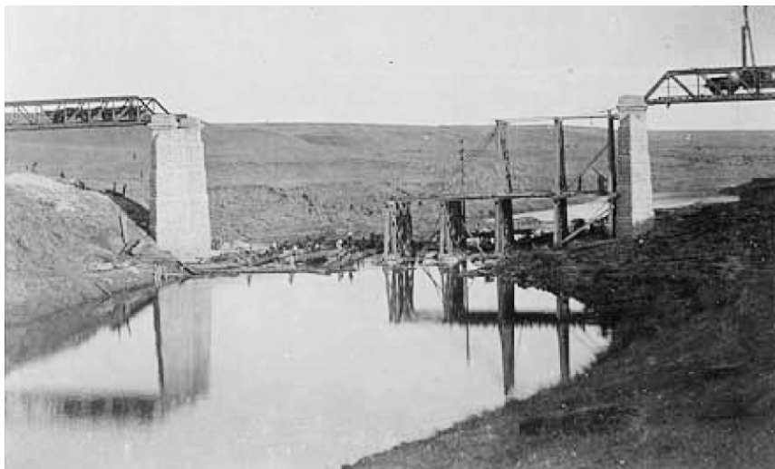
Восстановление разрушенных пролётов железнодорожного моста
