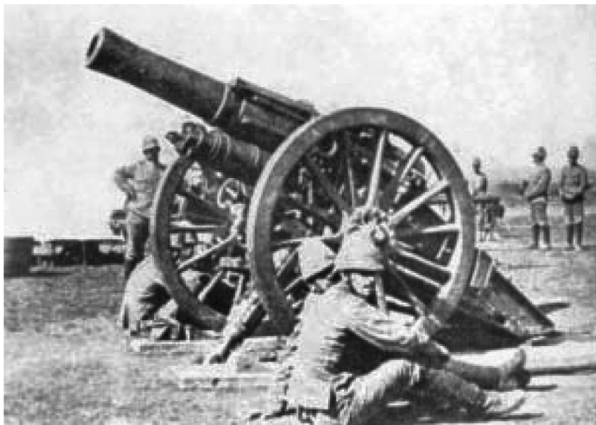
Английская полевая гаубица калибра 152,4 мм (6 дюймов)
