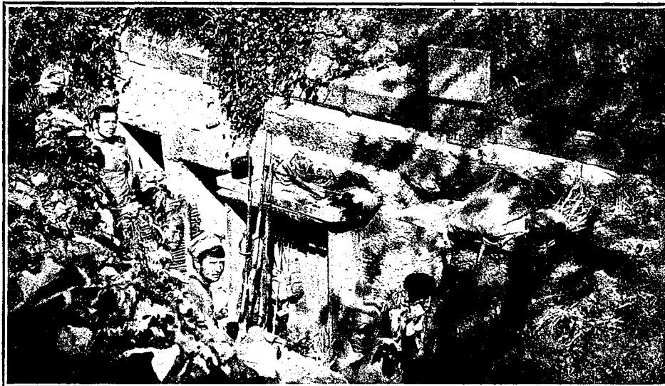
Къ черт. № 14. Бетонное убѣжище на кладбищѣ у церкви.
