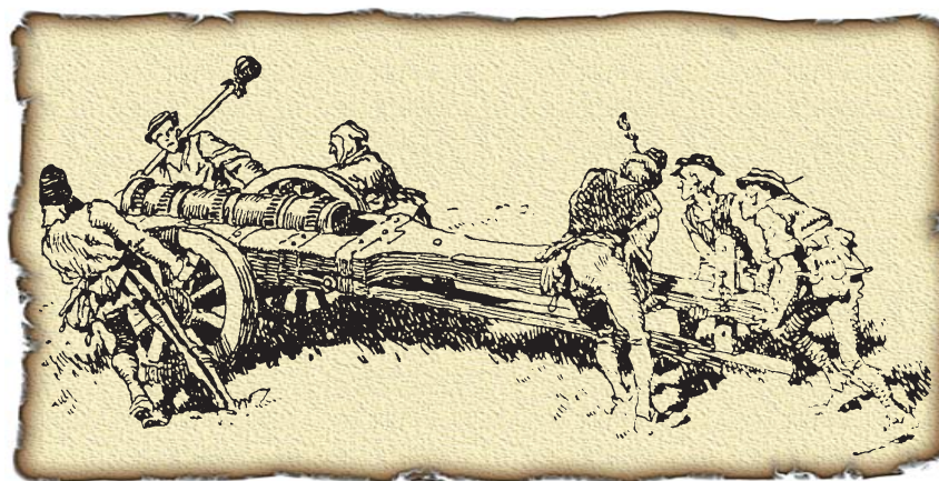
Кулеврина. Обычно длина ствола в 20—40 раз больше его ширины. Подъем ствола осуществляется при помощи простого механизма, расположенного в задней части лафета
